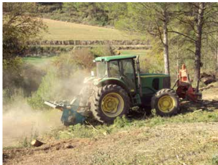
Imatge 10: ADF realitzant obres de prevenció d'incendis . Font: FPG.
