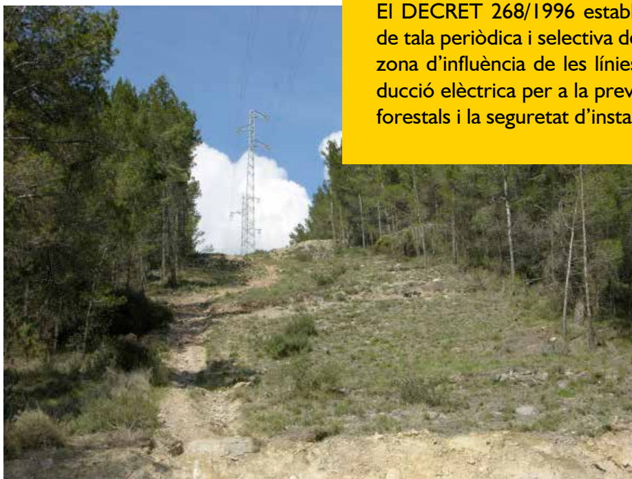
Imatge 5: Línia elèctrica amb la vegetació del corredor eliminada. Font: DGF.
