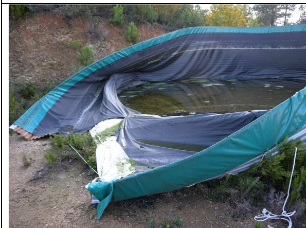
Foto PA esbardellat després de posar la lona i durant les tasques de l'omplenat, observi's el rovell de la xapa
