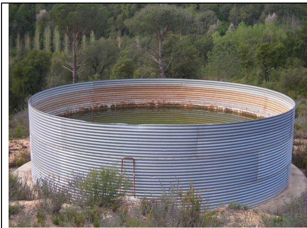
Foto del rovell interior de la xapa
